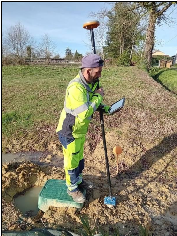
MIRAMONT-SENSACQ Repérage d'un branchement - pointage GPS
