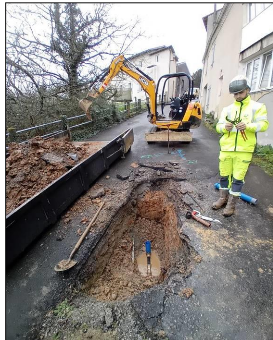
SAMADET - Réparation d'une fuite chemin de Depès
