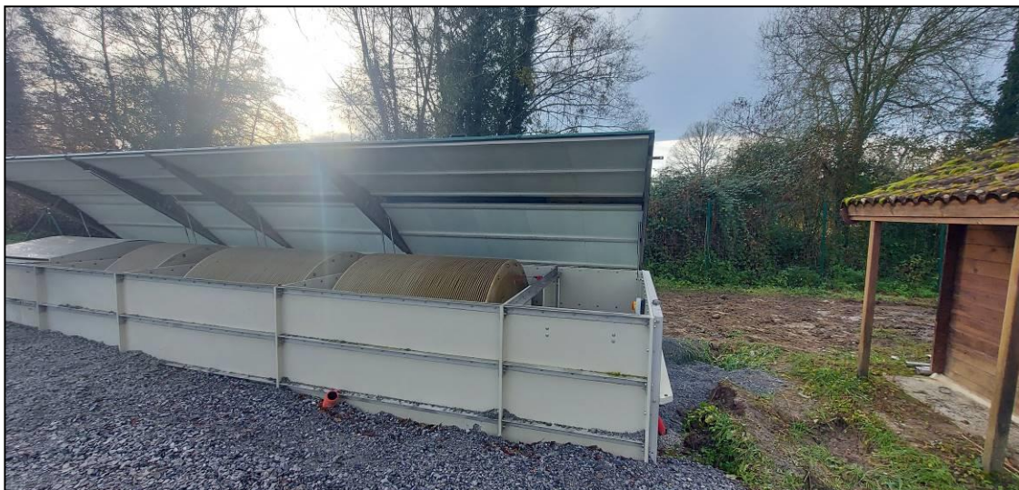
Chantier d'extension de la station d'épuration de Mazerolles de 495 EH à 750 EH
