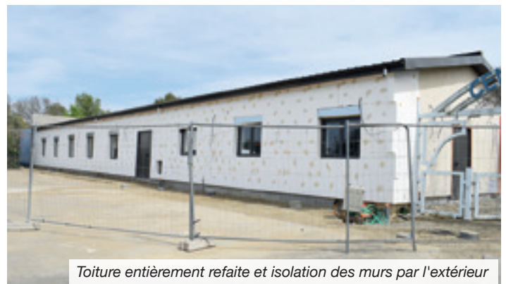
Travaux du réfectoire
